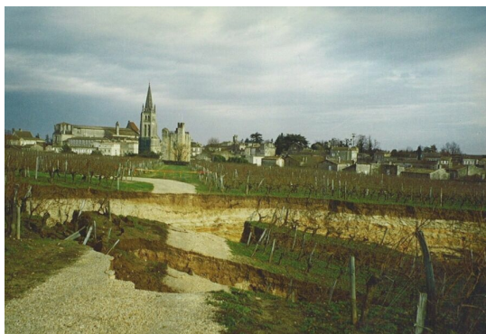
Effondrement du 30 décembre 1997, commune de Saint-Emilion, lieu-dit « La Madeleine »
