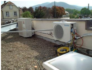
Sur le toit derrière un mur acrotère
