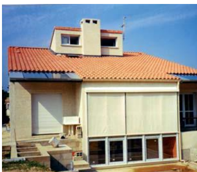
Sur les avancés de toit en brise soleil
