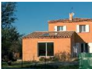
Intégré à la toiture de l'extension
