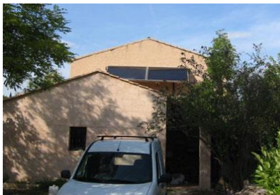
En garde-corps au-dessus d'un pan de toit
