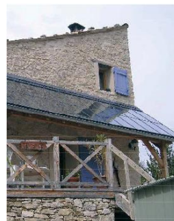
En couverture d'une pergola
