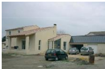
Continuité de façade
