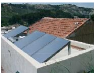
Derrière un mur acrotère en toiture
